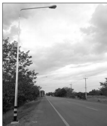
ติดตั้งบนสะพาน/ทางแยก/จุดที่ต้องการความสว่างเพิ่ม เสาไฟแบบกิ่งเดี่ยว (Single Pole)
