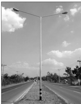
ติดตั้งบริเวณสายทางก่อนทางแยก/สะพาน เสาไฟแบบกิ่งคู่ (Double Pole)
