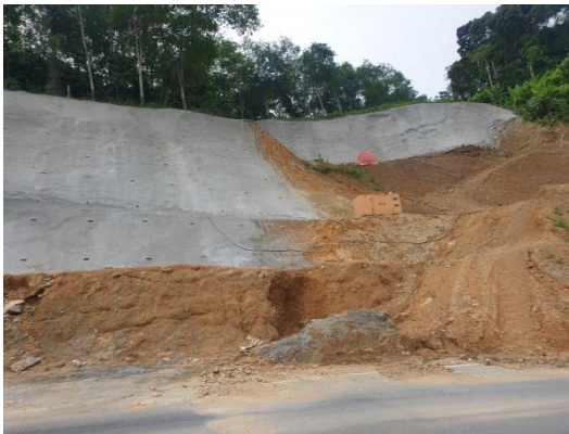
รูปที่ 6.4-4 จุดป้องกันการพังทลายหน้าดิน/ดินสไลด์ กม.115+950
