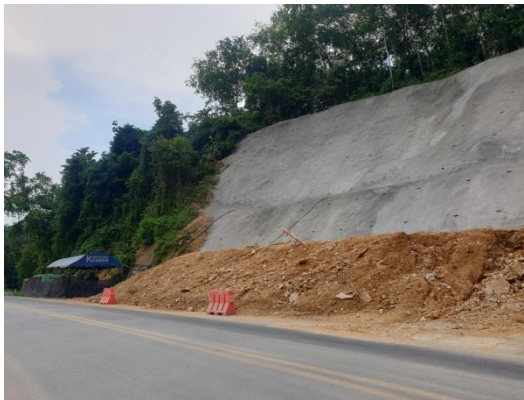
รูปที่ 6.4-4 จุดป้องกันการพังทลายหน้าดิน/ดินสไลด์ กม.115+950
