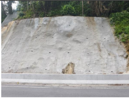
รูปที่ 6.4-3 จุดป้องกันการพังทลายหน้าดิน/ดินสไลด์ กม.114+750
