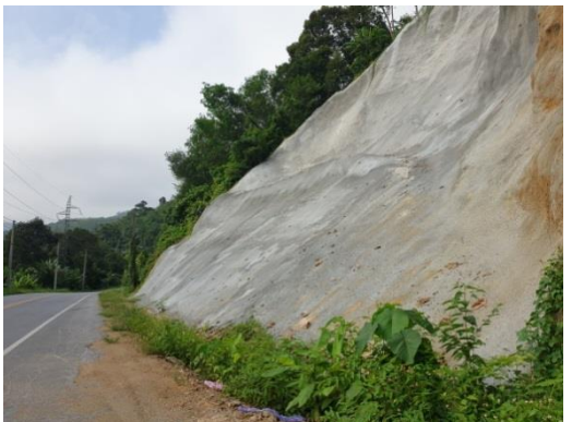
รูปที่ 6.4-5 จุดป้องกันการพังทลายหน้าดิน/ดินสไลด์ กม.125+550
