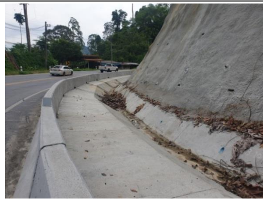
รูปที่ 6.4-3 จุดป้องกันการพังทลายหน้าดิน/ดินสไลด์ กม.114+750
