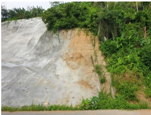
รูปที่ 6.4-5 จุดป้องกันการพังทลายหน้าดิน/ดินสไลด์ กม.125+550
