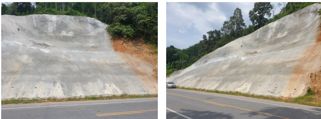
รูปที่ 6.4-2 จุดป้องกันการพังทลายหน้าดิน/ดินสไลด์ กม.105+700
